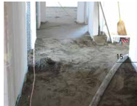
Coulage de la chape
