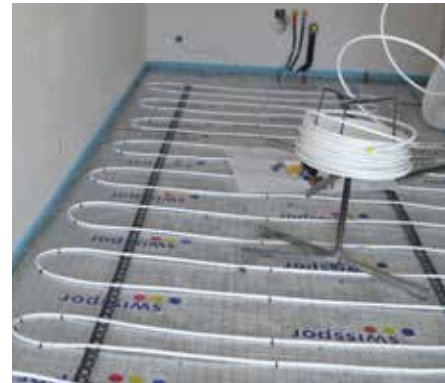
Pose des tuyaux de chauffage
