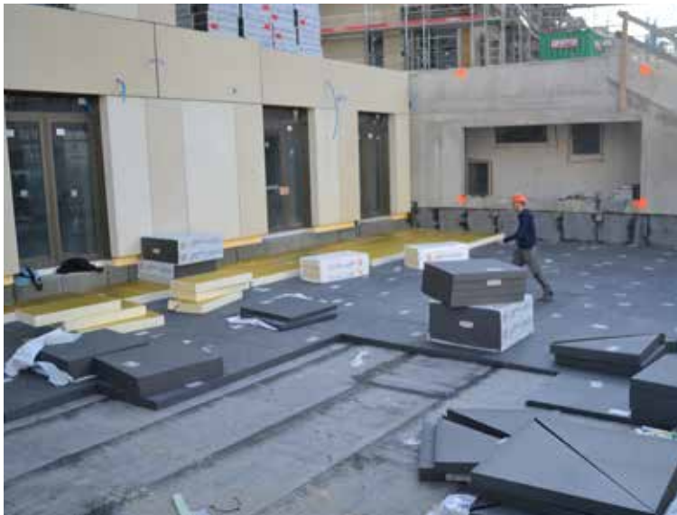
La pente dans l'isolation, simple et rapide
