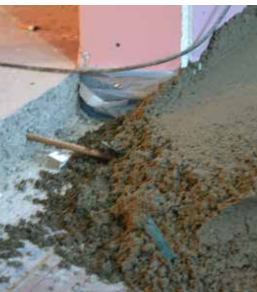
Une isolation sous chape résistant aux fortes charges, particulièrement adaptée pour les ols commerciaux
